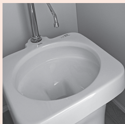
車いすトイレの横にはオストメイト用のコーナーあり
